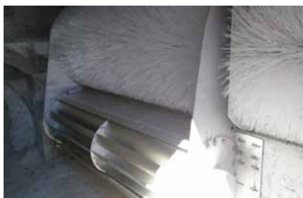
Fig. 15 – Sistema di grigliatura delle acque sfiorate installato nel manufatto sfioratore.
