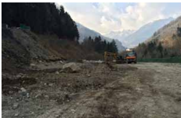
Fig. 4 - Il sito in località Dezzo a inizio lavori.
