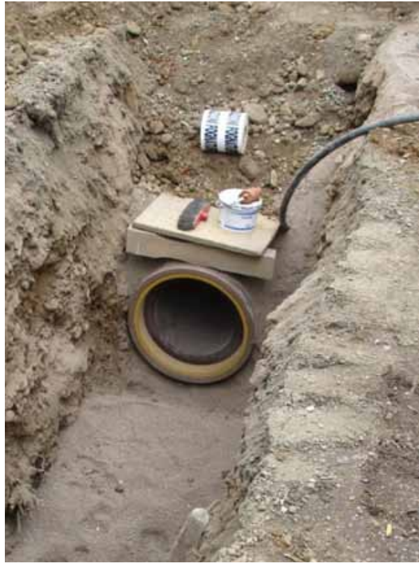
Fig. 11 – Particolare della posa del collettore.
