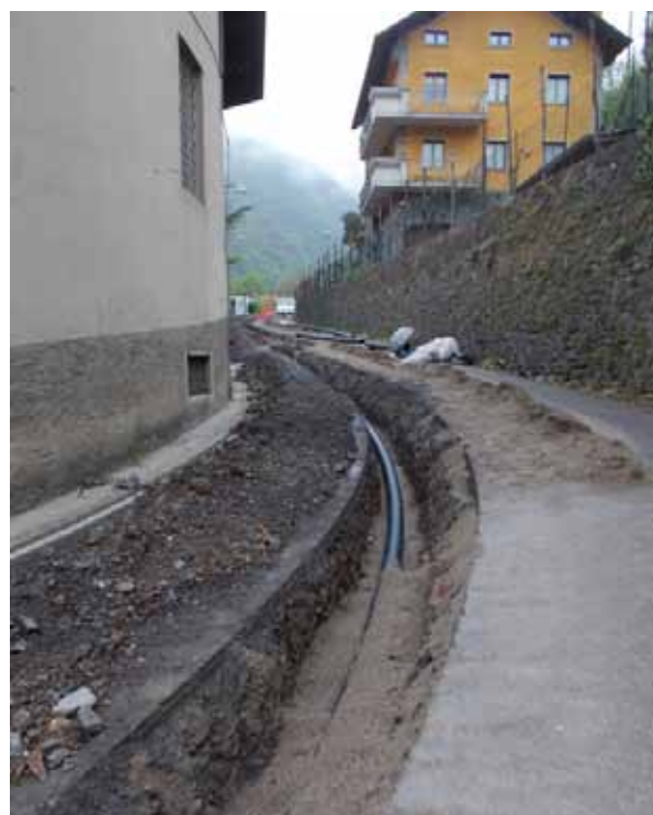
Fig. 13 – Posa tubazioni lungo via Romacolo.
