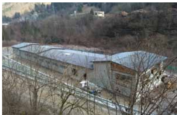
Fig. 5 - L'impianto a fine lavori.
