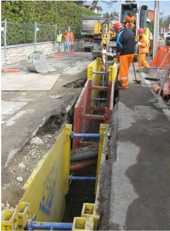
Fig. 10 – Blindoscavo lungo il tracciato di posa.
