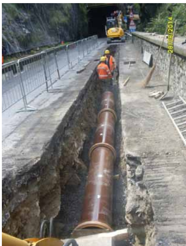
Fig. 8 – Particolare della posa tubazione
