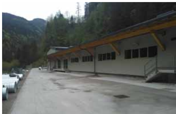
Fig. 7 - Esterno dell'impianto a fine lavori.
