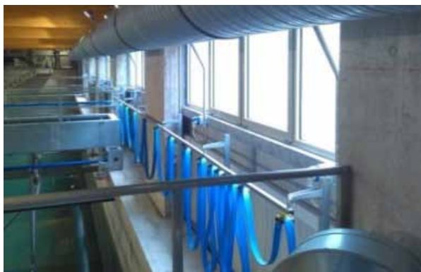
Fig. 6 - Interno dell'impianto a fine lavori.
