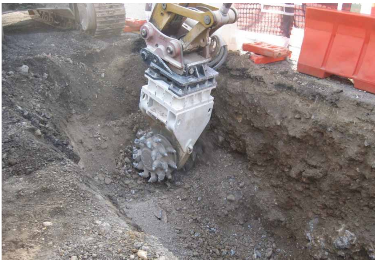
Foto 2: Fresa utilizzata per l'esecuzione degli scavi in presenza di roccia molto compatta
