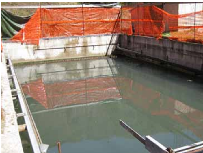
Foto 1: sedimentatore secondario prima dell'intervento
