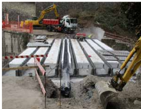
Foto 2: INTERVENTO URGENTE N° 2 particolare posa tubazione nell'impalcato del ponte
