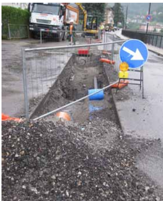
Foto 1: Posa tubazioni lungo via Dei Partigiani
