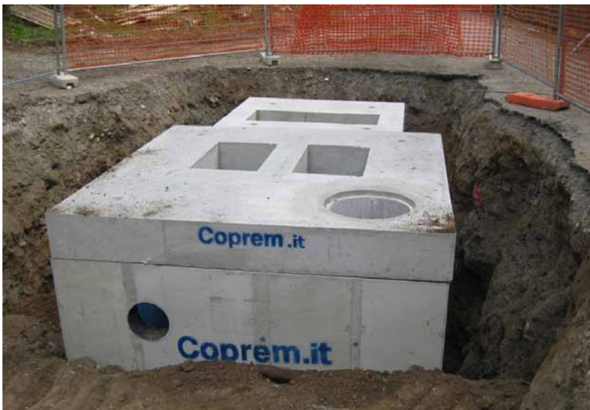
Foto 2: Vasca prefabbricata per stazione di sollevamento
