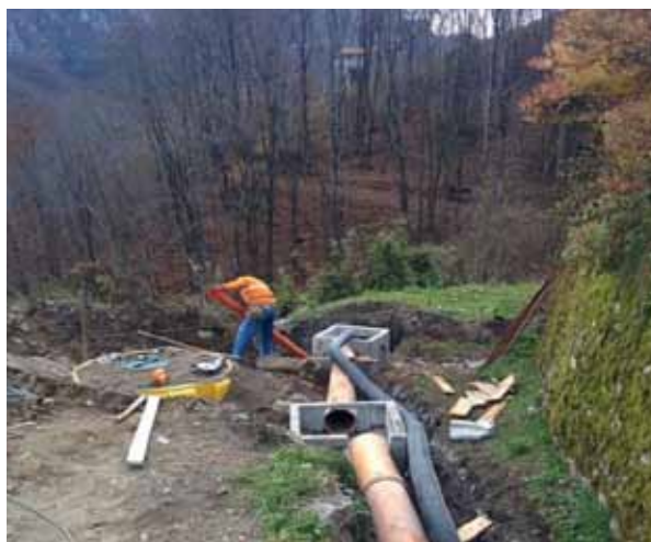
Foto 4: Lavori (La Costa)
