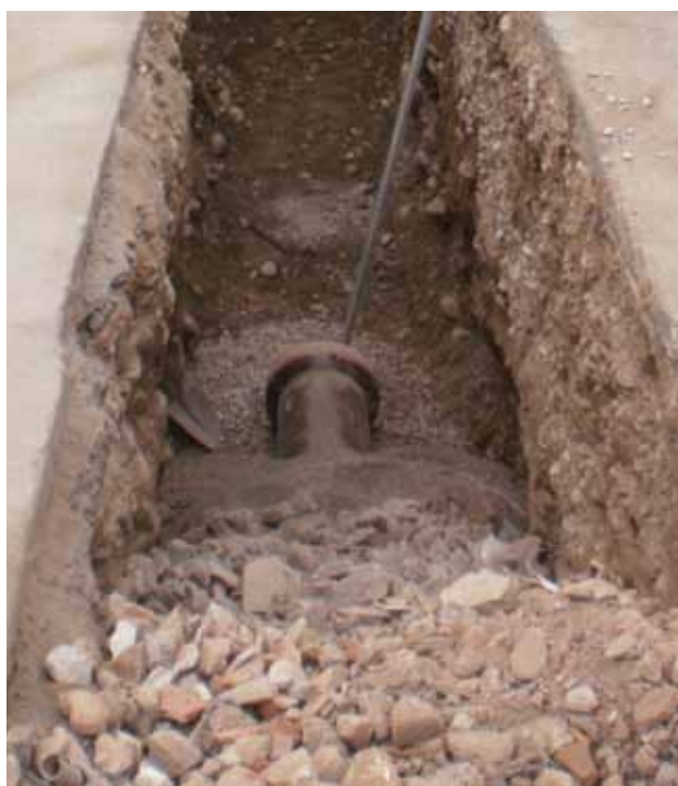
Foto 2: Posa condotta in via Basse
