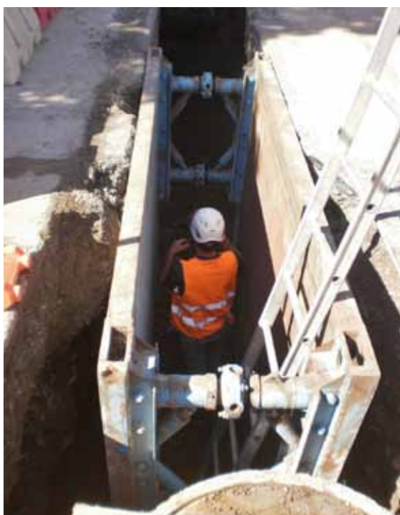
Foto 1: Posa condotta in via Grinetta
