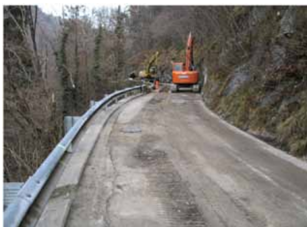
Foto 1: INTERVENTO URGENTE N° 1 particolare posa tubazione e cameretta
