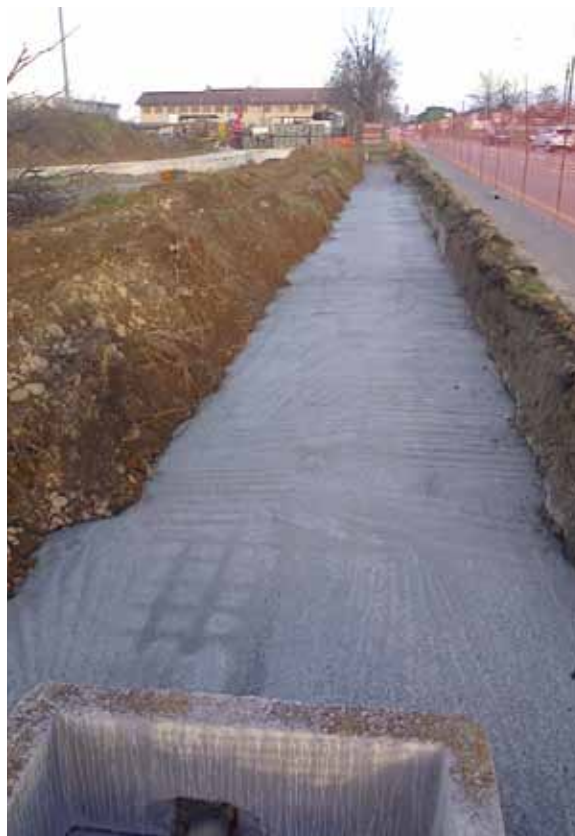
Foto 2: Protezione della condotta fognaria con struttura superiore in calcestruzzo armato
