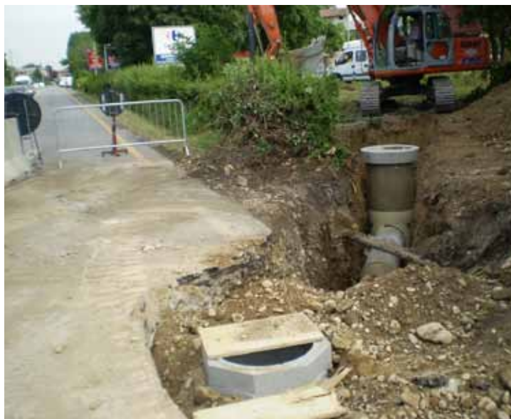
Foto 2: particolare posa tubazione e cameretta via Papa Giovanni
