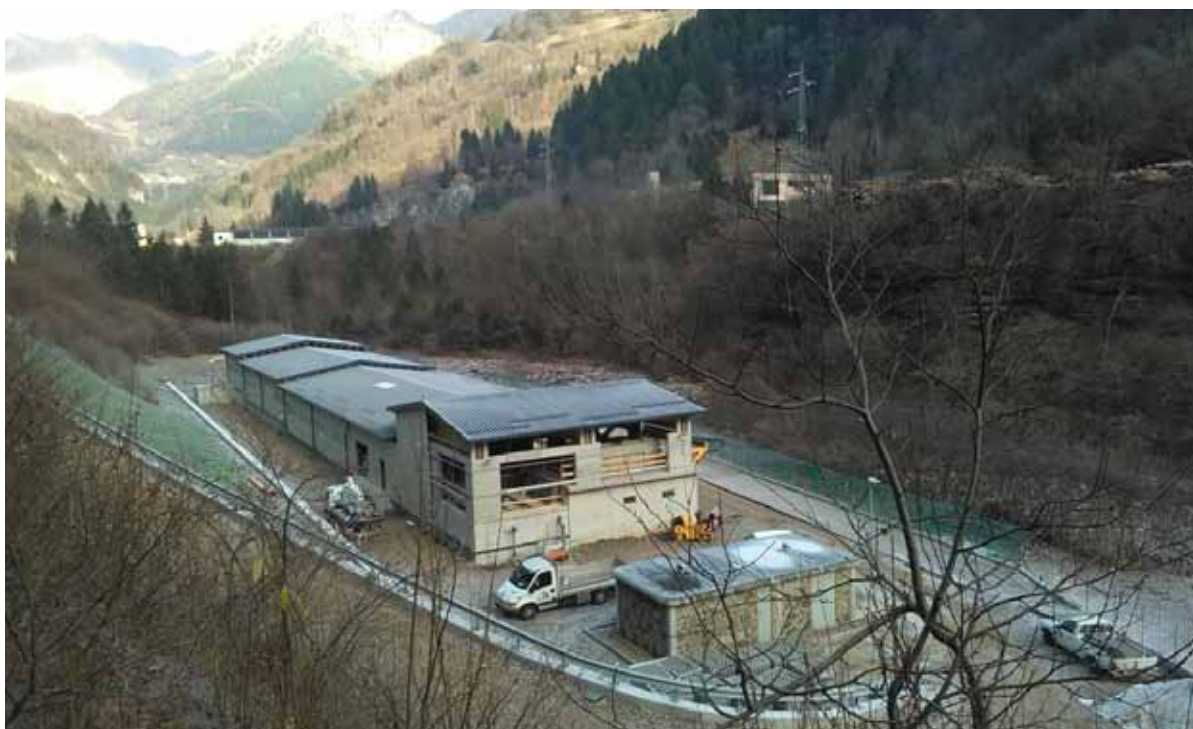
Foto 1: Lavori in corso
