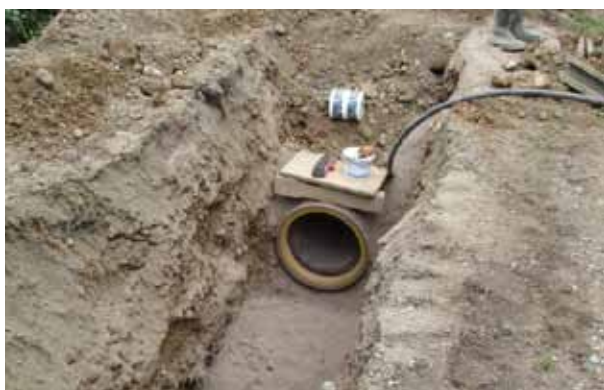
Foto 1: lavori di posa del collettore in gres
