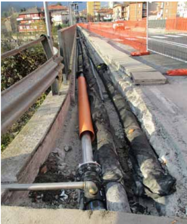
Foto 1: Posa tubazioni lungo il ponte di via Martiri della Libertà
