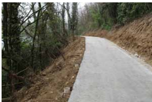
Foto 2: sistemazione della pista ciclopedonale (opera di compensazione)
