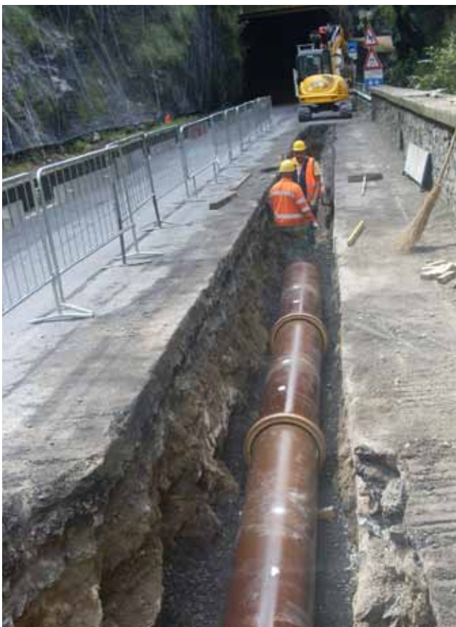
Foto 1: particolare posa tubazione
