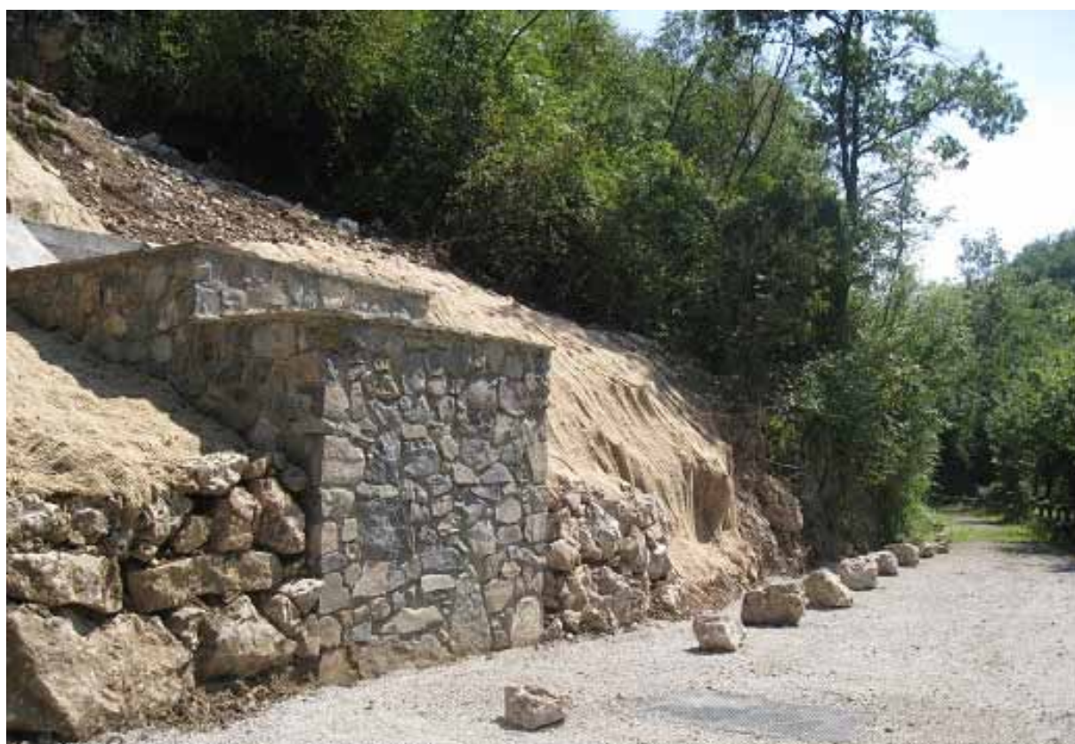
Foto 2: nuovo manufatto scolmatore
