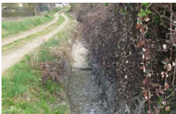
Foto 1: recapito delle acque sfiorate prima dell'intervento
