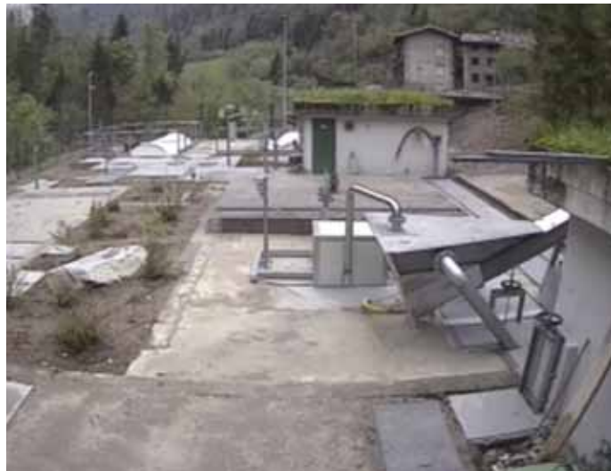
Foto 2: vista generale dell'impianto di depurazione a fine lavori
