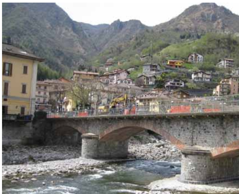
Foto 2: Posa tubazioni lungo il ponte Cavour
