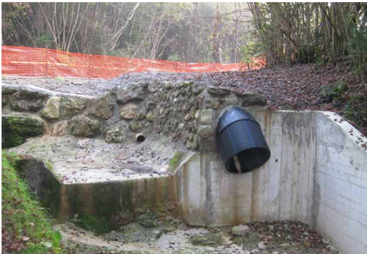
Foto 1: Scarico in valletta da nuovo manufatto scolmatore
