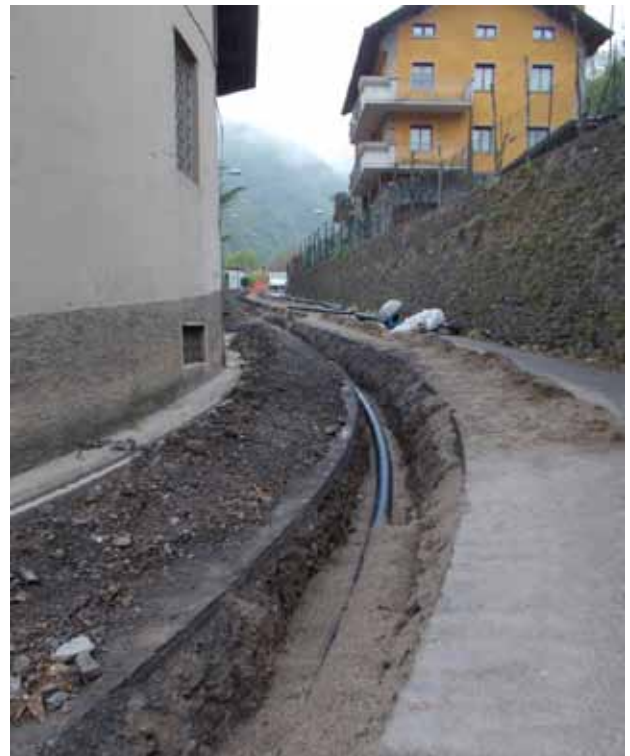
Foto 2: Posa tubazioni lungo via Romacolo
