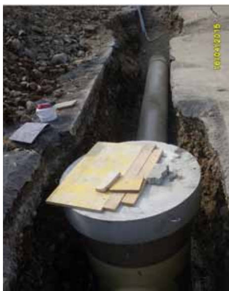
Foto 1: particolare posa tubazione e cameretta via Crema
