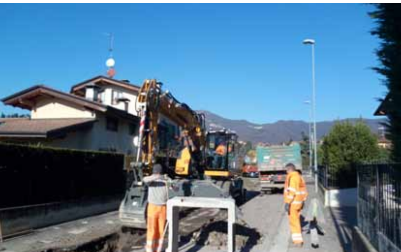
LAVORI IN VIA ROMA
