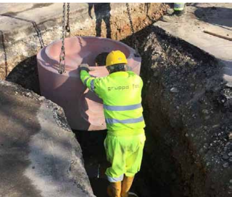
LAVORI RETE FOGNARIA
