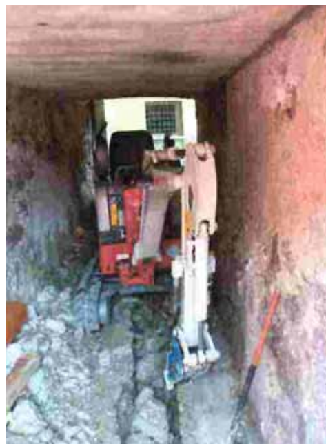
POSA COLLETTORE IN PVC Ø 200 mm. IN VICOLO MILESI - LAVORI NEL TRATTO COPERTO IN CENTRO STORICO
