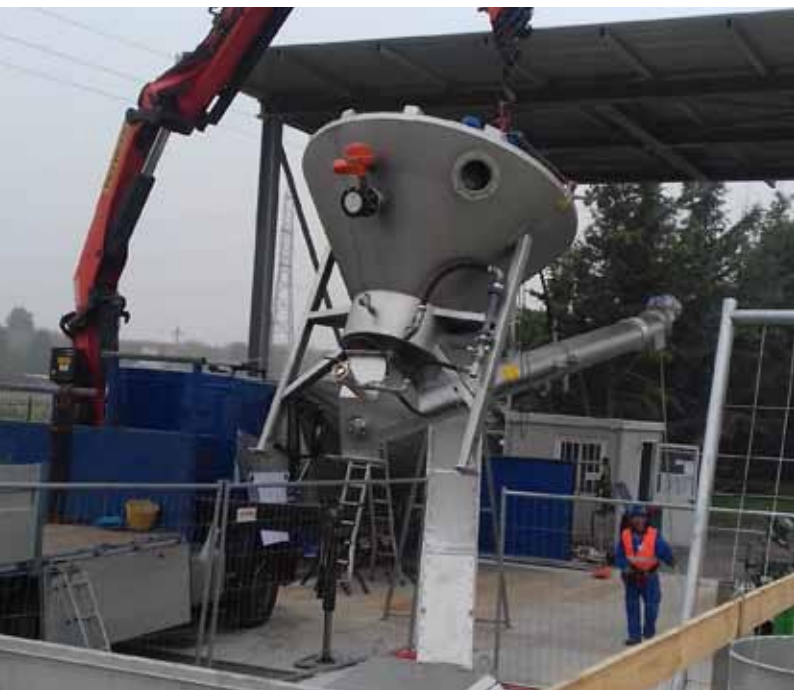
POSIZIONAMENTO DEL CLASSIFICATORE SABBIE
