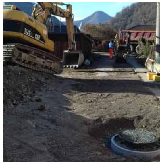
REALIZZAZIONE DEL COLLETTAMENTO DEI TERMINALI NON DEPURATI
