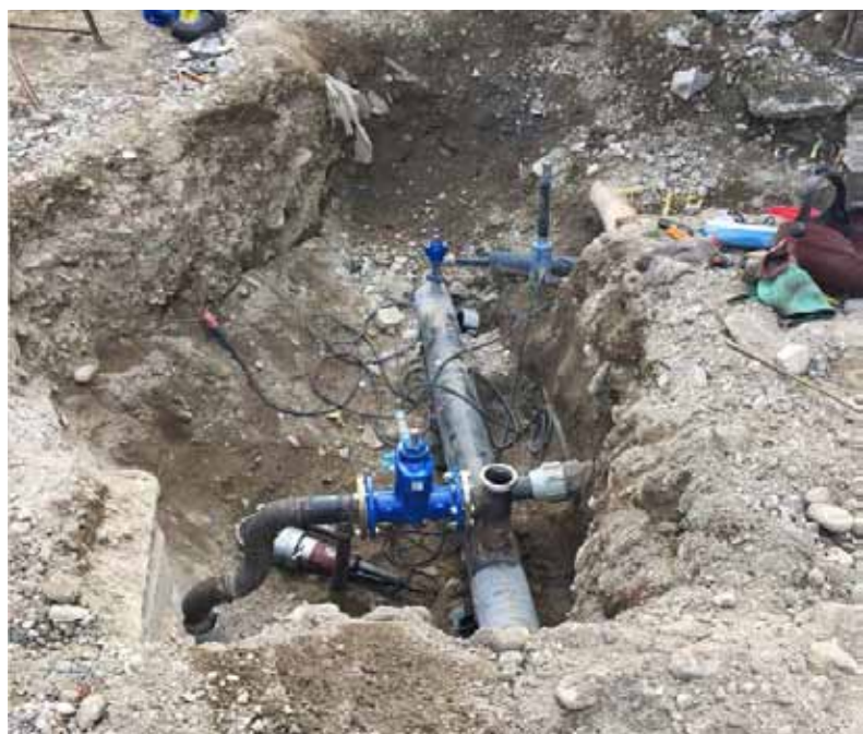
LAVORI RETE IDRICA
