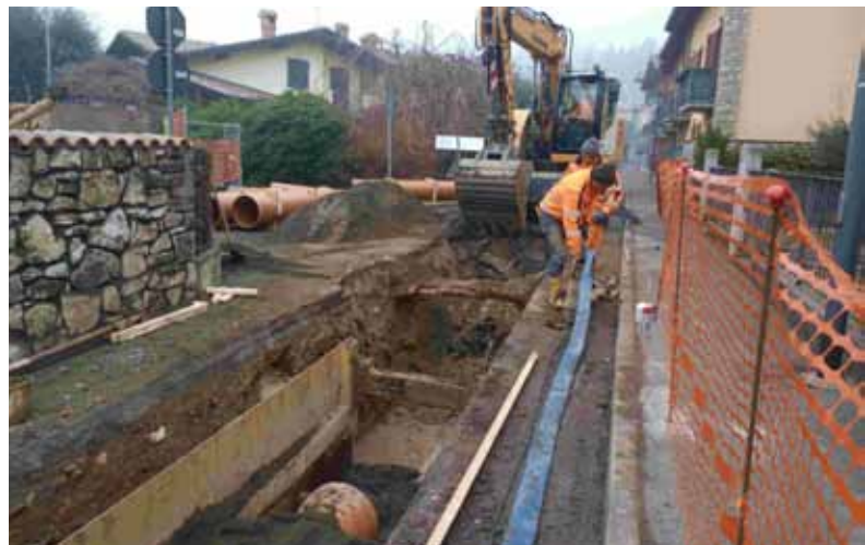
LAVORI IN VIA MORONI
