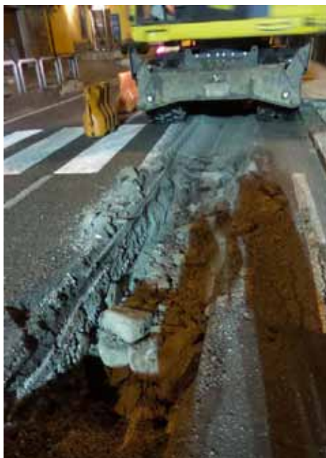
POSA COLLETTORE IN GRES Ø 500 mm. LUNGO VIA BOSELLI (S.P.ex S.S. 470) - ESECUZIONE DEI LAVORI IN ORARIO NOTTURNO
