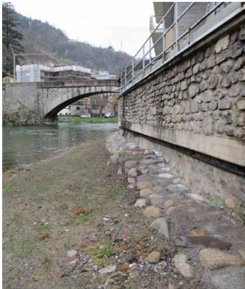
SELCIATO REALIZZATO A PROTEZIONE DELLA NUOVA TUBAZIONE
