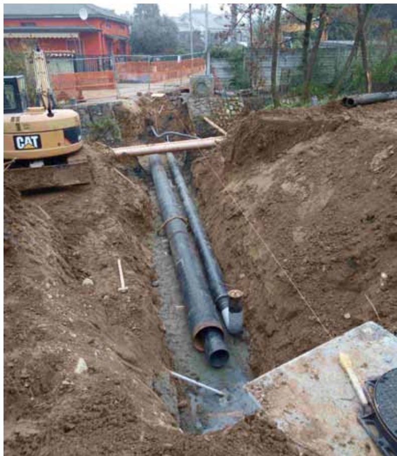
NUOVE TUBAZIONI IN ATTRAVERSAMENTO AL TORRENTE TIRNA
