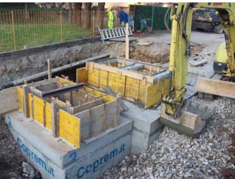
INTERVENTO POSA STAZIONE DI SOLLEVAMENTO IN VIA MOLINA
