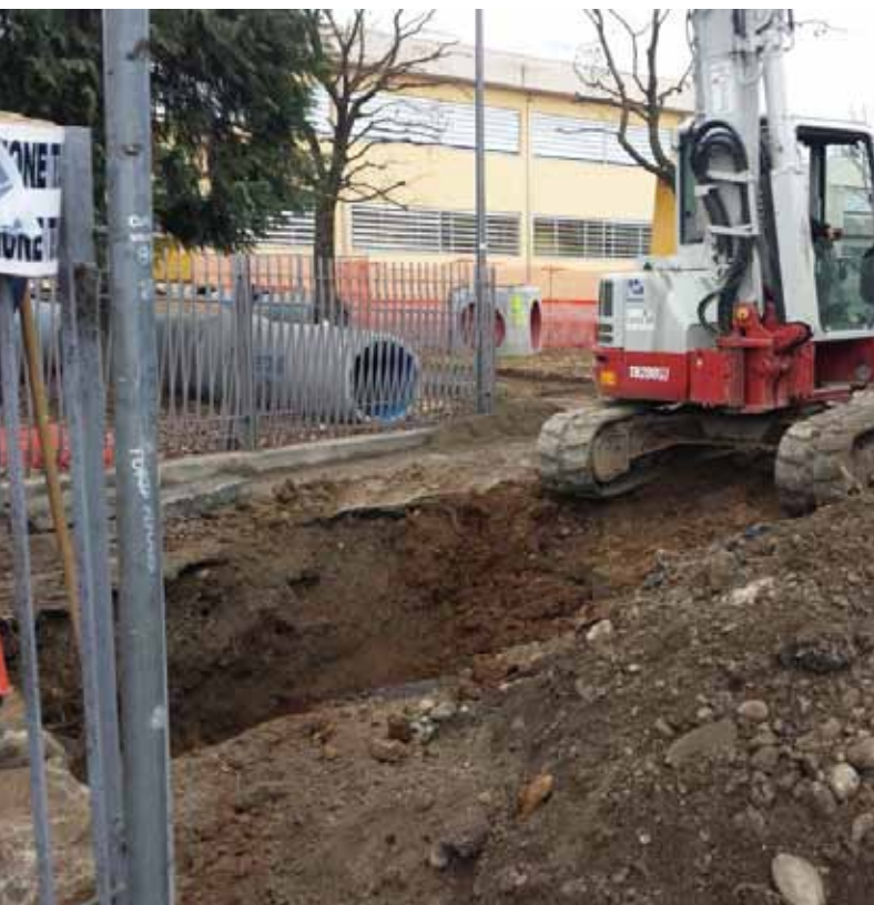
INTERVENTO INTERNO ALLA SCUOLA
