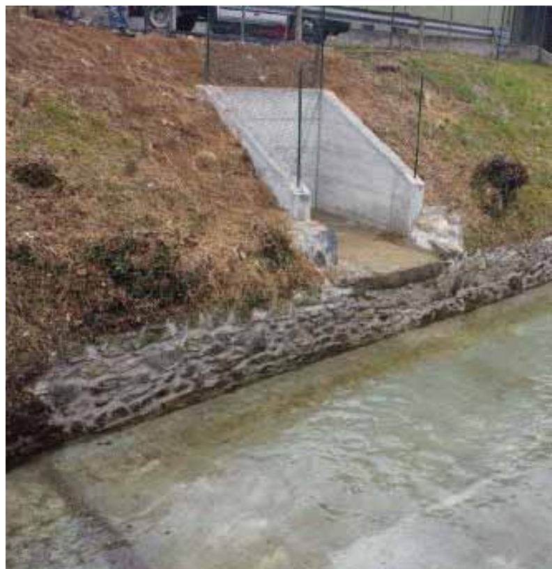
MANUFATTO DI SCARICO IN ROGGIA
