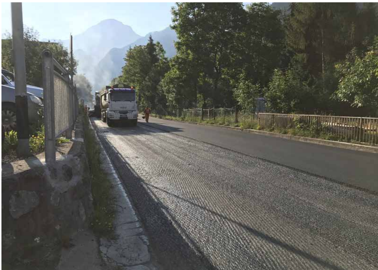
S.P. 294 VIA CORNIOLA – LAVORI DI ASFALTATURA
