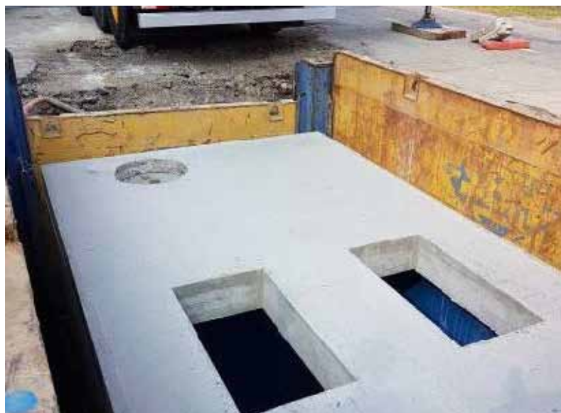
LAVORI DI REALIZZAZIONE DELLA STAZIONE DI SOLLEVAMENTO SS2 IN LOCALITÀ SAN ROCCO POSA MANUFATTI PREFABBRICATI DEL VANO POMPE (DIMENSIONI 3,00X3,00XH3,25)
