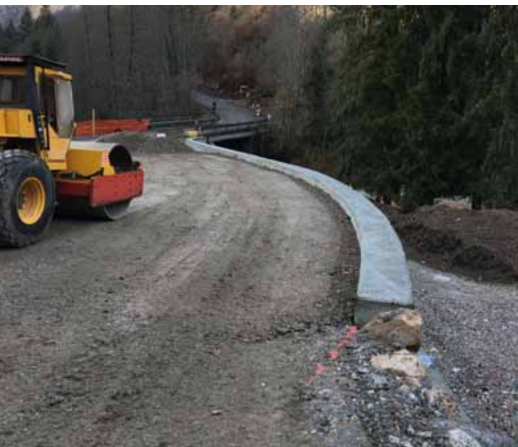
REALIZZAZIONE NUOVA STRADA DI VIA CAPRIANA
