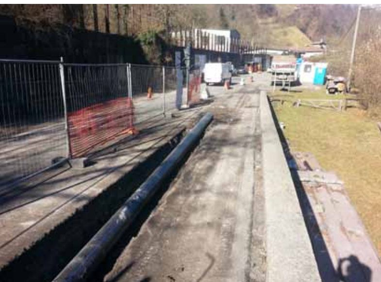
POSA DEL TRATTO DI COLLETTORE CON FUNZIONAMENTO PRESSURIZZATO IN VIA SAN ROCCO CONDOTTA DN 315 mm IN PE 100 PN16 CONTENUTA IN GUAINA DN 400 mm IN PVC SN8
