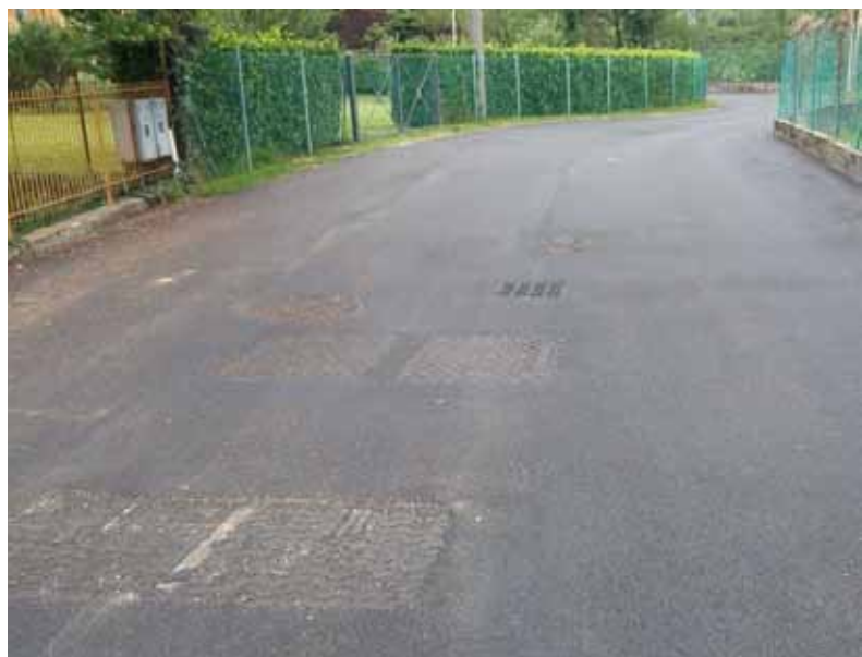
ULTIMAZIONE INTERVENTO POSA STAZIONE DI SOLLEVAMENTO IN VIA MOLINA
