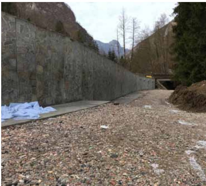
REALIZZAZIONE NUOVA STRADA DI VIA CAPRIANA MURO DI SOSTEGNO
