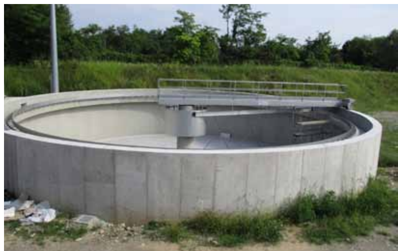
NUOVO SEDIMENTATORE SECONDARIO
