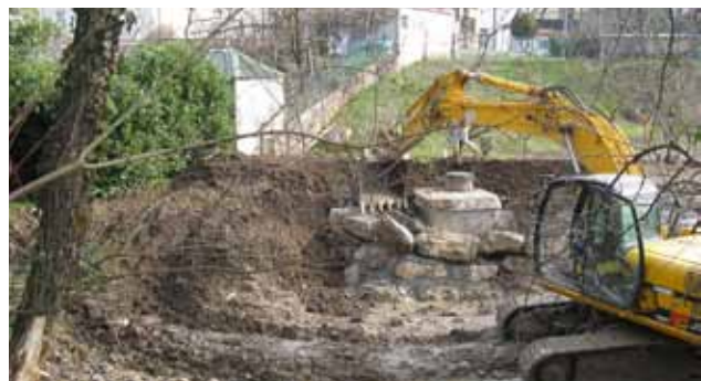
MESSA IN PROTEZIONE DELLO SFIORATORE
