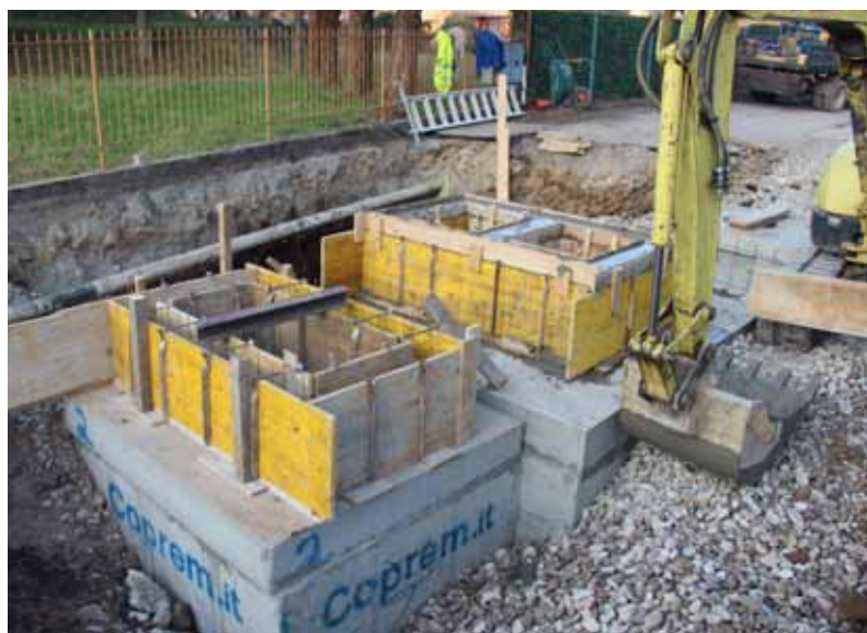
INTERVENTO - POSA STAZIONE SOLLEVAMENTO
