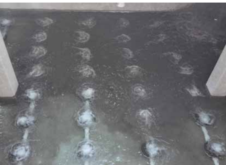
NUOVO SISTEMA DI DIFFUSIONE ARIA IN NITRIFICAZIONE
