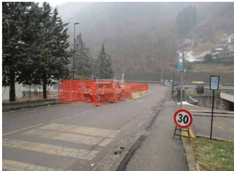
LAVORI PRESSO PONTE DONIZETTI
