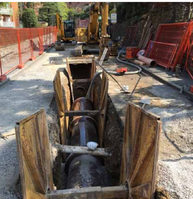
POSA CONDOTTA GRES DN 600
