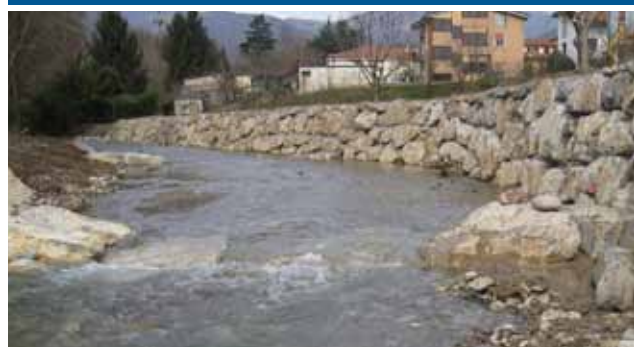
SISTEMAZIONE FINALE CON REALIZZAZIONE DELLA SCOGLIERA
