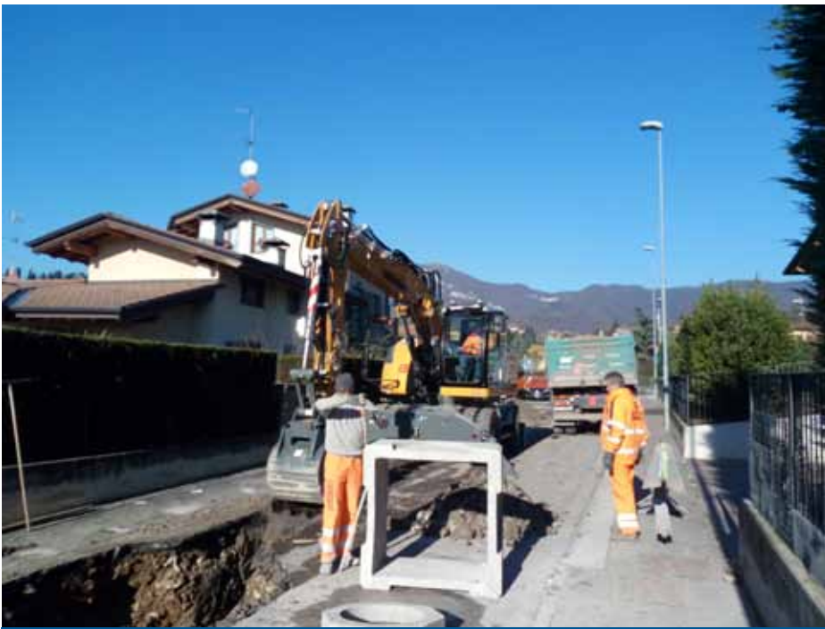
LAVORI DI VIA ROMA
