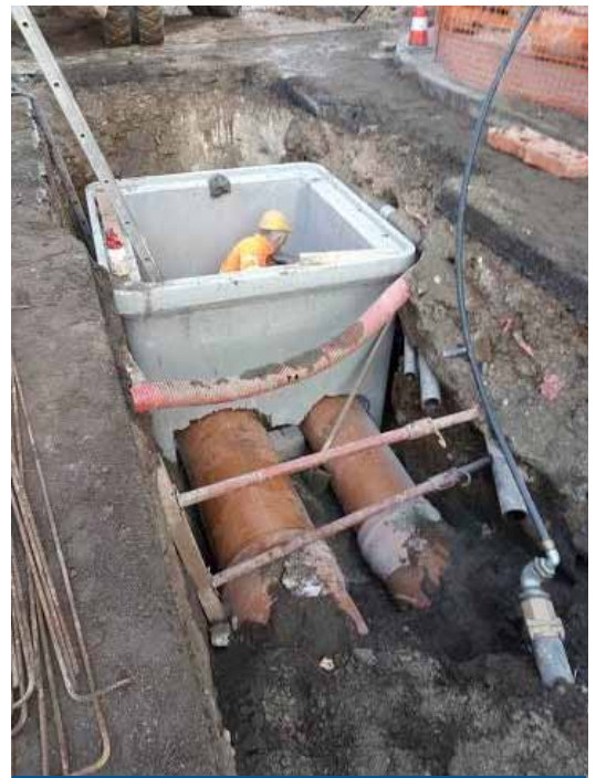
LAVORI DI VIA MORONI
