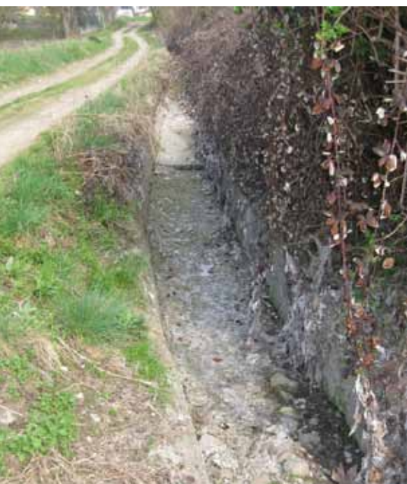
RECAPITO DELLE ACQUE SFIORATE PRIMA DELL'INTERVENTO
