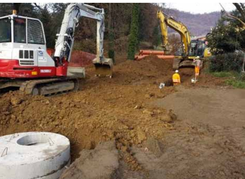
PRE-INTERVENTO – INIZIO POSA TUBAZIONI
