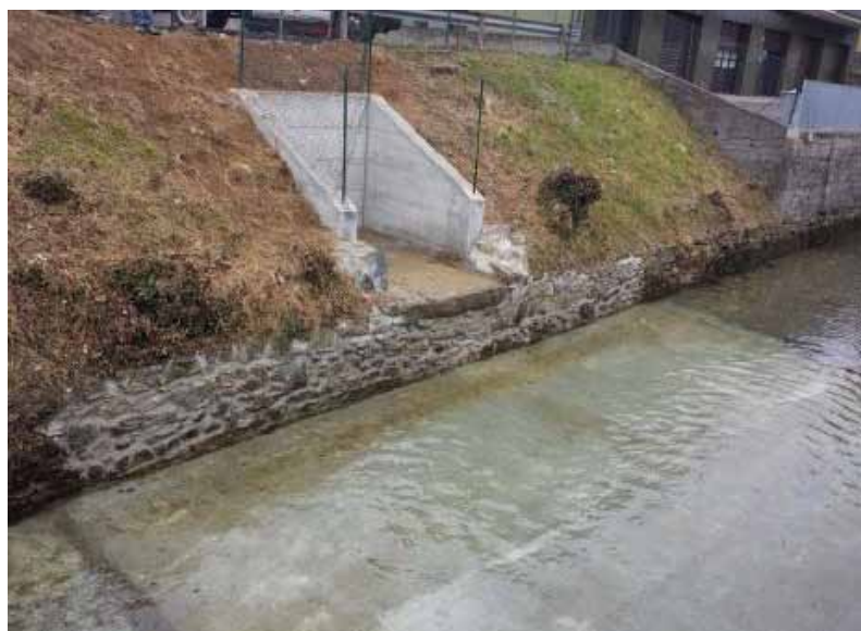
INTERVENTO – MANUFATTO SCARICO IN ROGGIA
