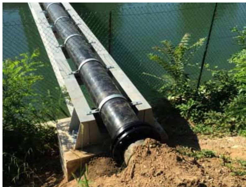
PARTICOLARE ATTRAVERSAMENTO CANALE IDROELETTRICO
