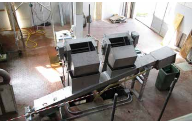
NUOVE GRIGLIE E COMPATTATORE DEL GRIGLIATO
