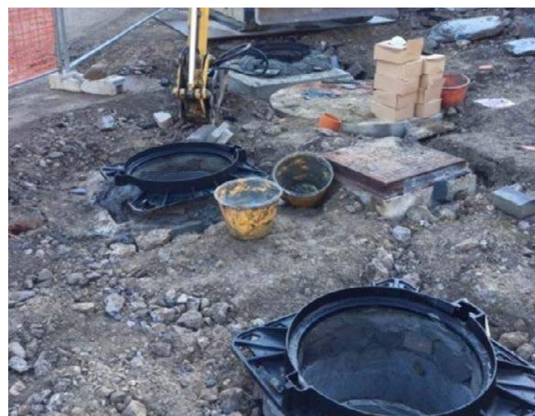
REALIZZAZIONE FOSSA IMHOFF AD ALINO
