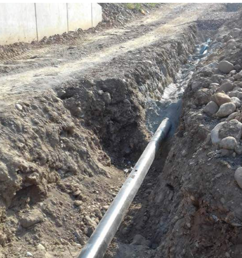
REALIZZAZIONE DI ACQUEDOTTO – VIA LUNGA – CURNO
