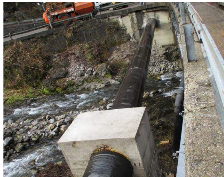
ATTRAVERSAMENTO TORRENTE AMBRIA
