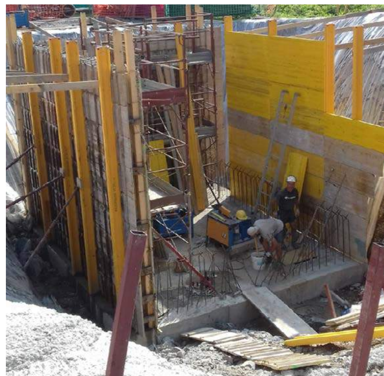
REALIZZAZIONE STAZIONE DI SOLLEVAMENTO
