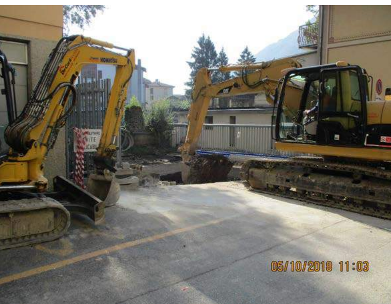
SCAVI PER REALIZZAZIONE STAZIONE DI SOLLEVAMENTO
