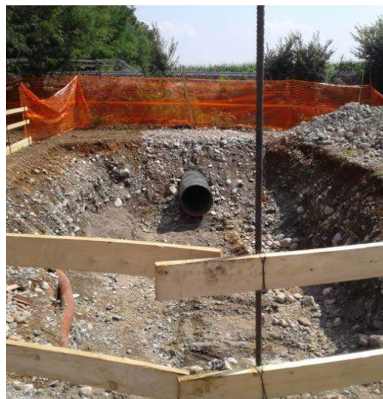
ATTRAVERSAMENTO LINEA FERROVIARIA CON SPINGI-TUBO
