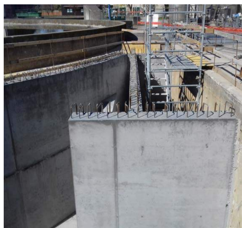
VISTA DELL'AMPLIAMENTO DELLA VASCA DI OZONIZZAZIONE
