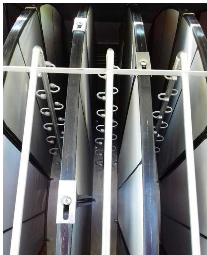
DETTAGLIO TELE FILTRANTI
