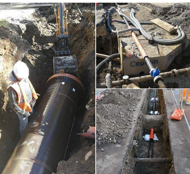
POSIZIONAMENTO MANUFATTI E RISOLUZIONE INTERFERENZE
