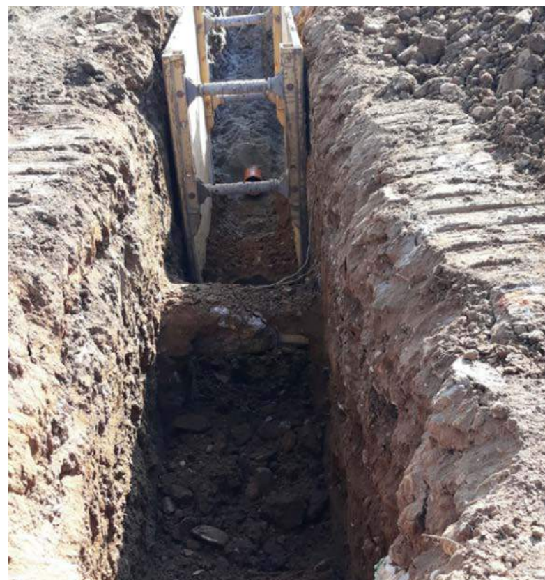
REALIZZAZIONE DI FOGNATURA – VIA DALMINE – CURNO
