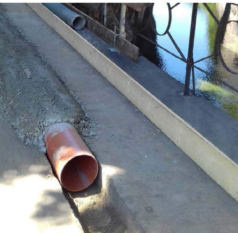
POSA TUBAZIONE LUNGO L'EX-SEDIME FERROVIARIO
