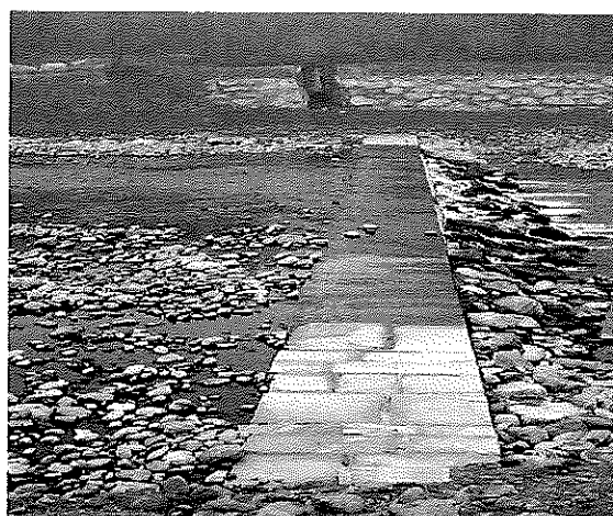
Fig. 11 – L'alveo del fiume ripristinato.
