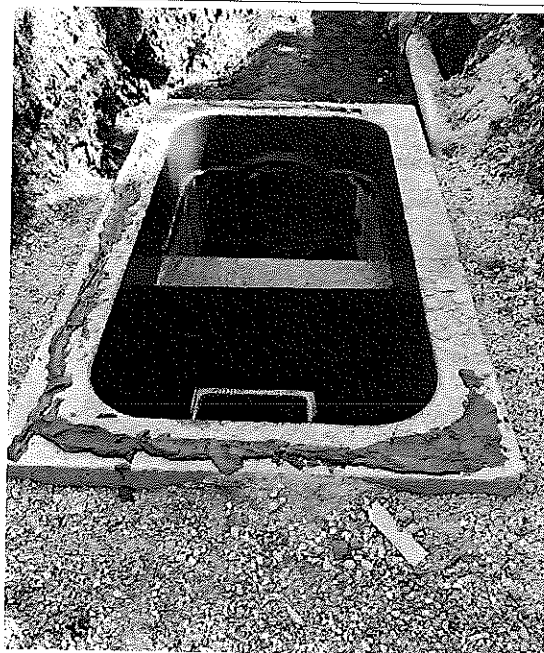
Fig. 15 – Particolare della cameretta di salto.
