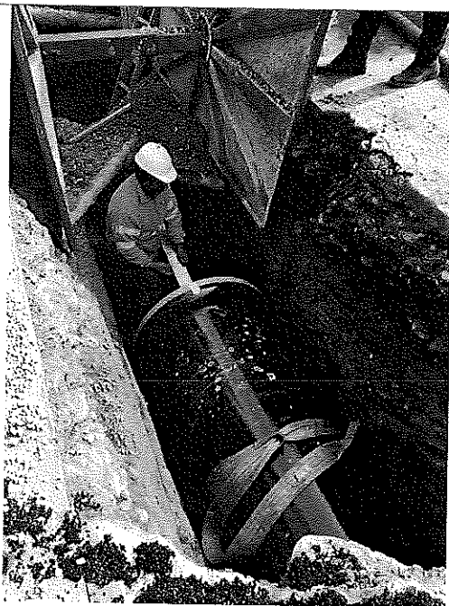
Fig. 14 – Posa condotta gres DN 600.
