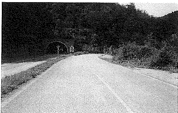
Fig. 8 – Il tratto interessato dai lavori.
