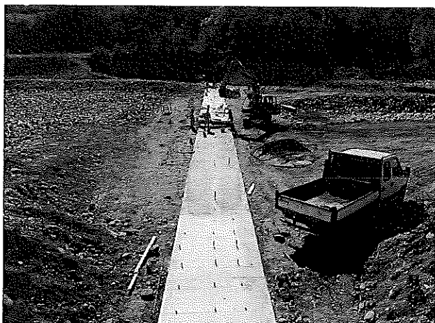
Fig. 10 – Opere di rinforzo del manufatto di protezione della tubazione.
