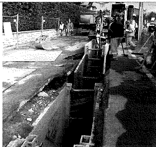
Fig. 10 – Blindoscavo lungo il tracciato di posa.
