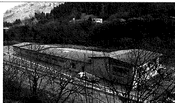
Fig. 5 - L'impianto a fine lavori.
